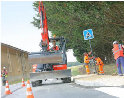
Traversée piétonne sur la D18 entre Saint-Julien et Tercé (Trembloux).
